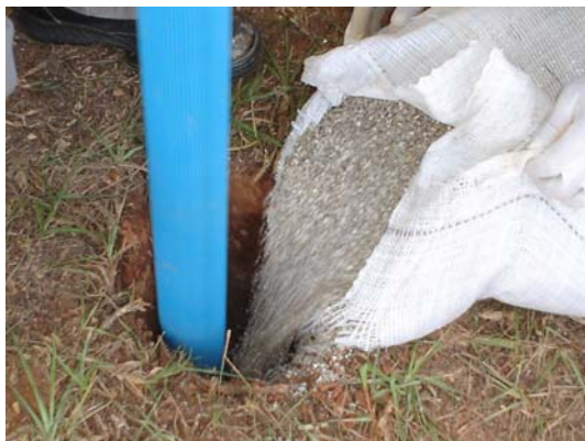
Foto 03 – Colocação de pré-filtro no poço
