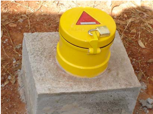
Foto 05 – Proteção externa do poço
