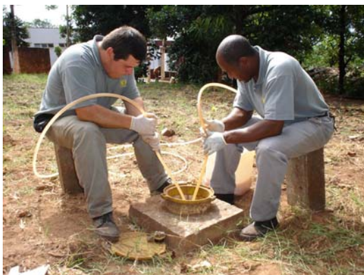
Foto 07 – Purga manual dos poços
