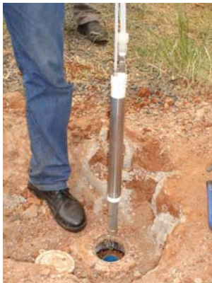
Foto 13 – Detalhe da bomba de bexiga
