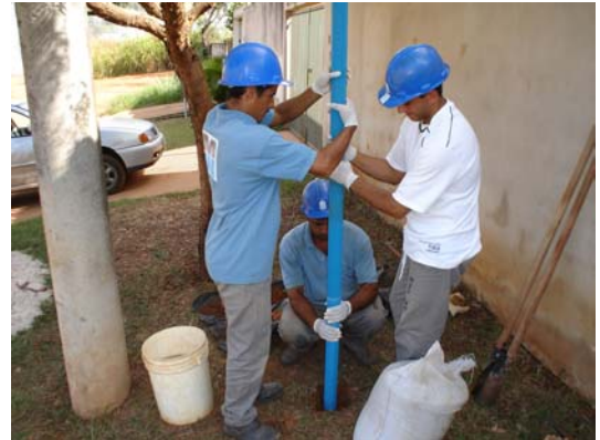
Foto 02 – Revestimento do poço com tubo geomecânico
