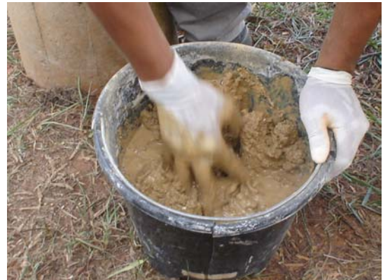
Foto 04 – Preparação do selo de bentonita
