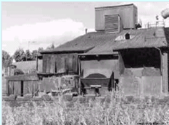
Incinerador en Byker, Reino Unido. © Ralph Ryder/CATs
