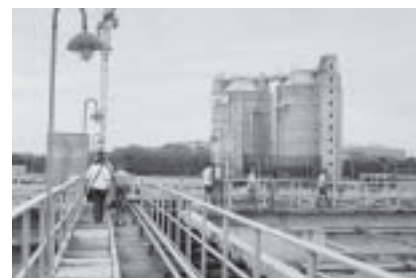
Estação de Tratamento de Esgoto Alegria Município do Rio de Janeiro PEA/PDBG/UERJ 2002
