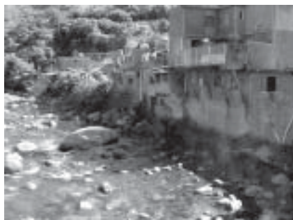
Ocupação irregular em margem de rio Município de Cachoeiras de Macacu 2004
